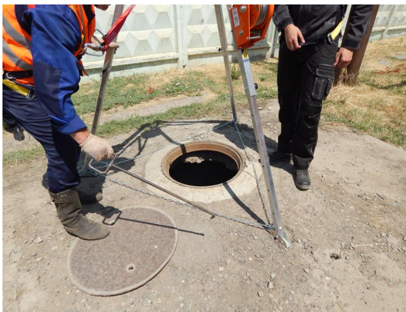
Фото 8. Открывание крышки люка специальным крюком
