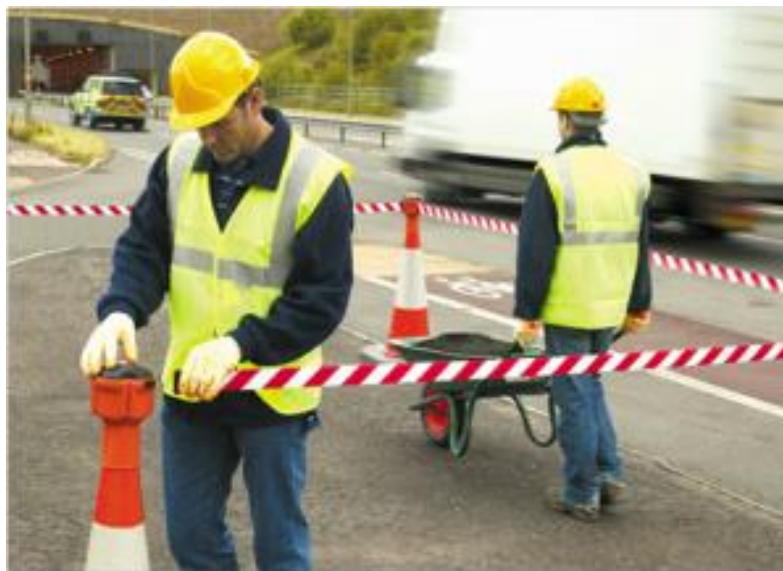
Фото 5. Установка сигнального ограждения
