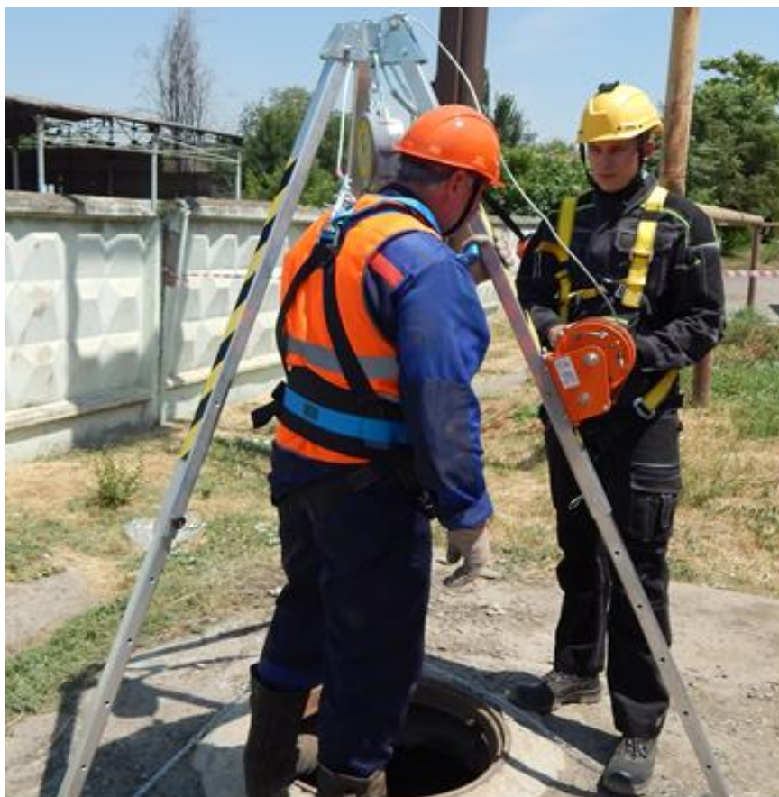
Фото 2. Крепление троса лебедки для эвакуации к задней (спинной) точке «А» страховочной привязи работника
