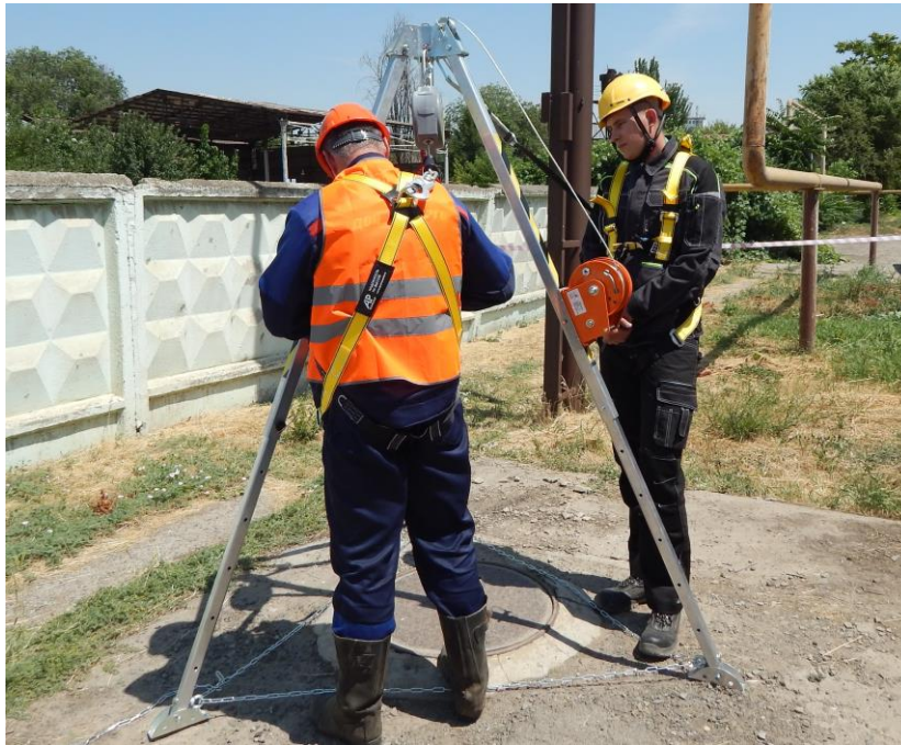
Фото 7. Закрепление систем безопасности до открытия крышки люка
